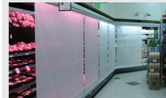
離峰時段使用塑膠捲簾，有效防止低溫逸散
